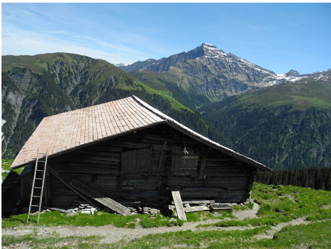
Situation nach der Dachsanierung mit original Safier Holzschindeln
