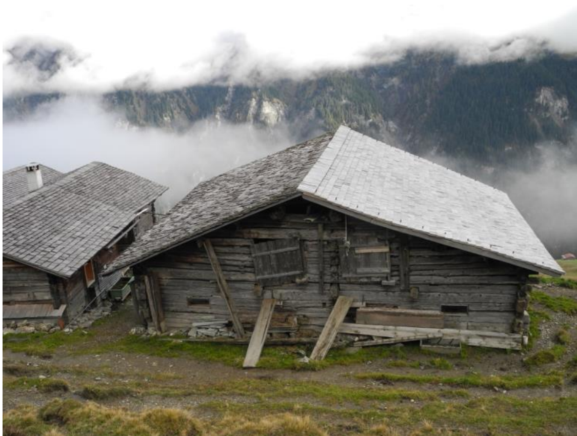
Situation vor der Dachsanierung einer Alphütte in Zalön 2016
