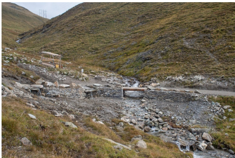
Abbildung 11: Tomülpass - Brücke, Furt und Abflussrinnen wurden in traditioneller Natursteinbauweise erneuert.
