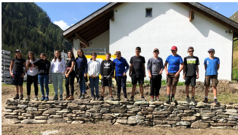
Abbildung 15: Jugendliche der Realschule Sternmatt 2 in Baar sanierten 18 Meter Trockensteinmauer in Nufenen (Bild: Deborah Vogel)
