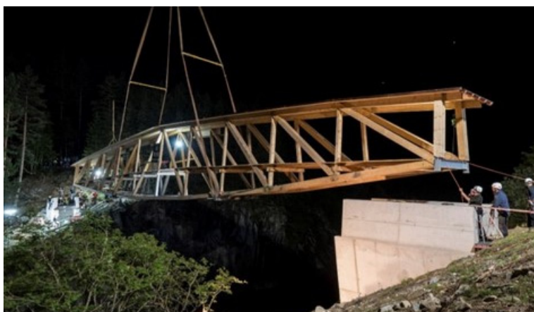
Abbildung 41: Die neue Holzbrücke über der Stausee Bärenburg konnte nur in der Nacht platziert werden.
