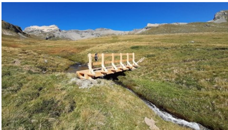
Abbildung 42: Bei der Wanderweg-Verlegung auf der Alp Anarosa wurden in Zusammenarbeit mit der Bergschaft Schams, Danilo Grischott und der Firma CSD über einen Bach und ein kleinräumiges Moor zwei Stege erstellt.
