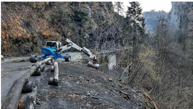
Abbildung 15: Strassenabbruch konnte mit einer Stützmauer gesichert und über eine Furt entwässert werden.
