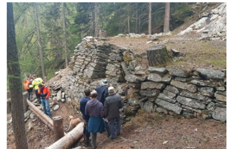
Abb. 16 Sanierungsarbeiten Seilbahn Gruobas
