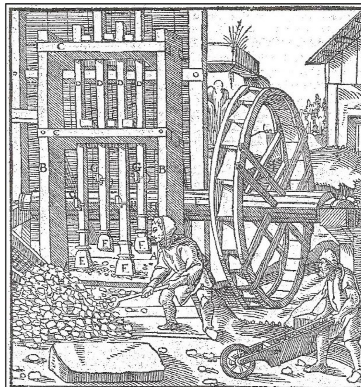
Abb. 11 Pochwerk zur Trennung des Erz von der wertlosen Gangart, Holzschnitt auf Papier (Georg Agricola)
