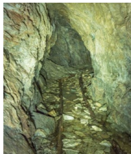
Abb. 10 Holzschienen für Erztransport in Ursera (Bruno Riedhauser)
