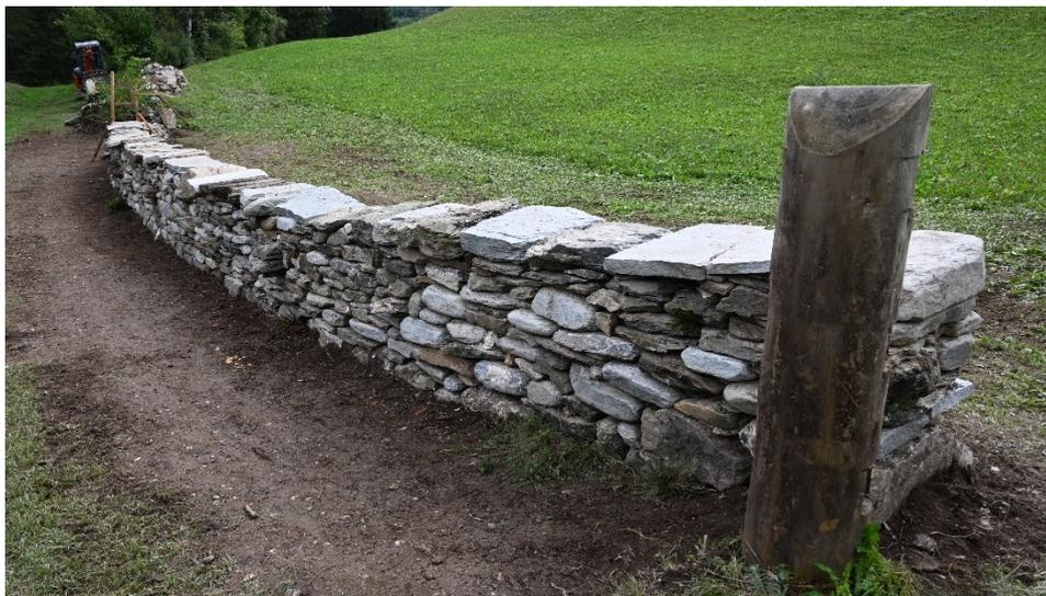
Abbildung 31: Trockensteinmauer Plans/Donat.
