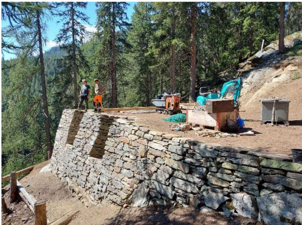
Abbildung 22: Die Plattform der Seilbahnstation nach vollendeter Restaurierung.
