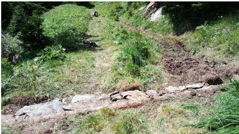
Abbildung 62: Zugewachsene Längsrinnen wurden wieder freigelegt, die Querabschläge gereinigt oder erneuert.
