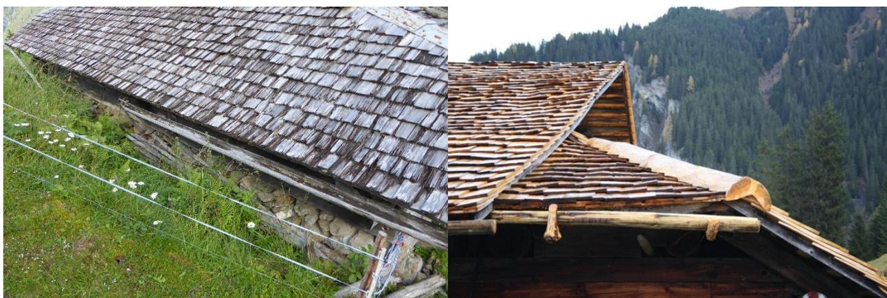
Abbildung 21: Zustand vor (links) und nach der Dachsanierung durch den Verein Safier Ställe.
