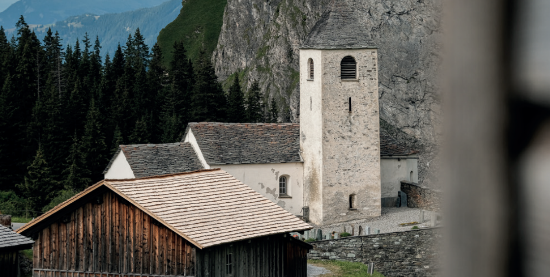
Der Stall bei der Kirche Thalkirch erstrahlt frisch beschindelt in neuem Glanz
