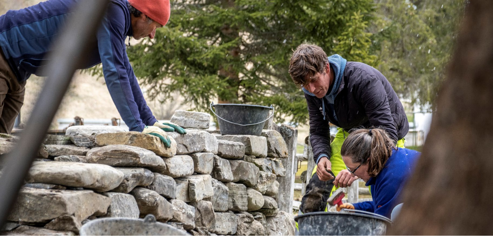
Im Rahmen des Trockenmauer-Baukurses lernten die Teilnehmenden das Jahrhunderte alte Kunsthandwerk kennen. (Foto: Naturpark Beverin / Florian Frey)
