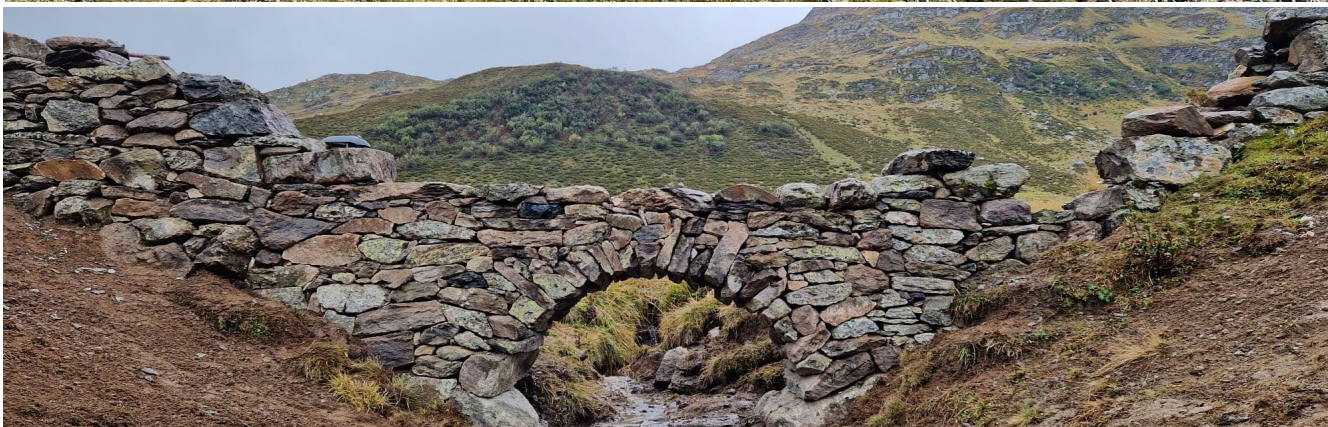
Eindrückliches Resultat eines Arbeitseinsatzes: Sanierung einer Trockensteinmauer auf der Alp Tambo. (Foto: Naturpark Beverin)
