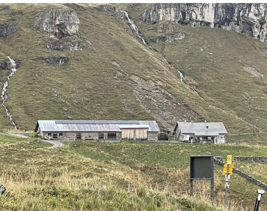
Die neu installierte Solaranlage hilft in trockenen Sommern den Strombedarf zu decken. (Foto: Naturpark Beverin, Paul Däscher)
